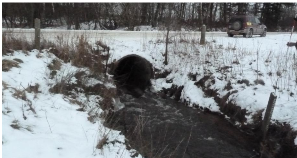
Figur 10 Eksisterende rørbro ved Skovbølling Dambrug set i opstrøms retning
